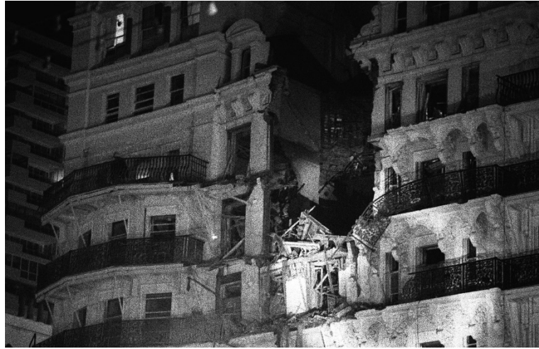
La fachada derruida del hotel Grand horas después de que detonara la bomba de Patrick Magee en la sexta planta, el 12 de octubre de 1984. (PA Images)
